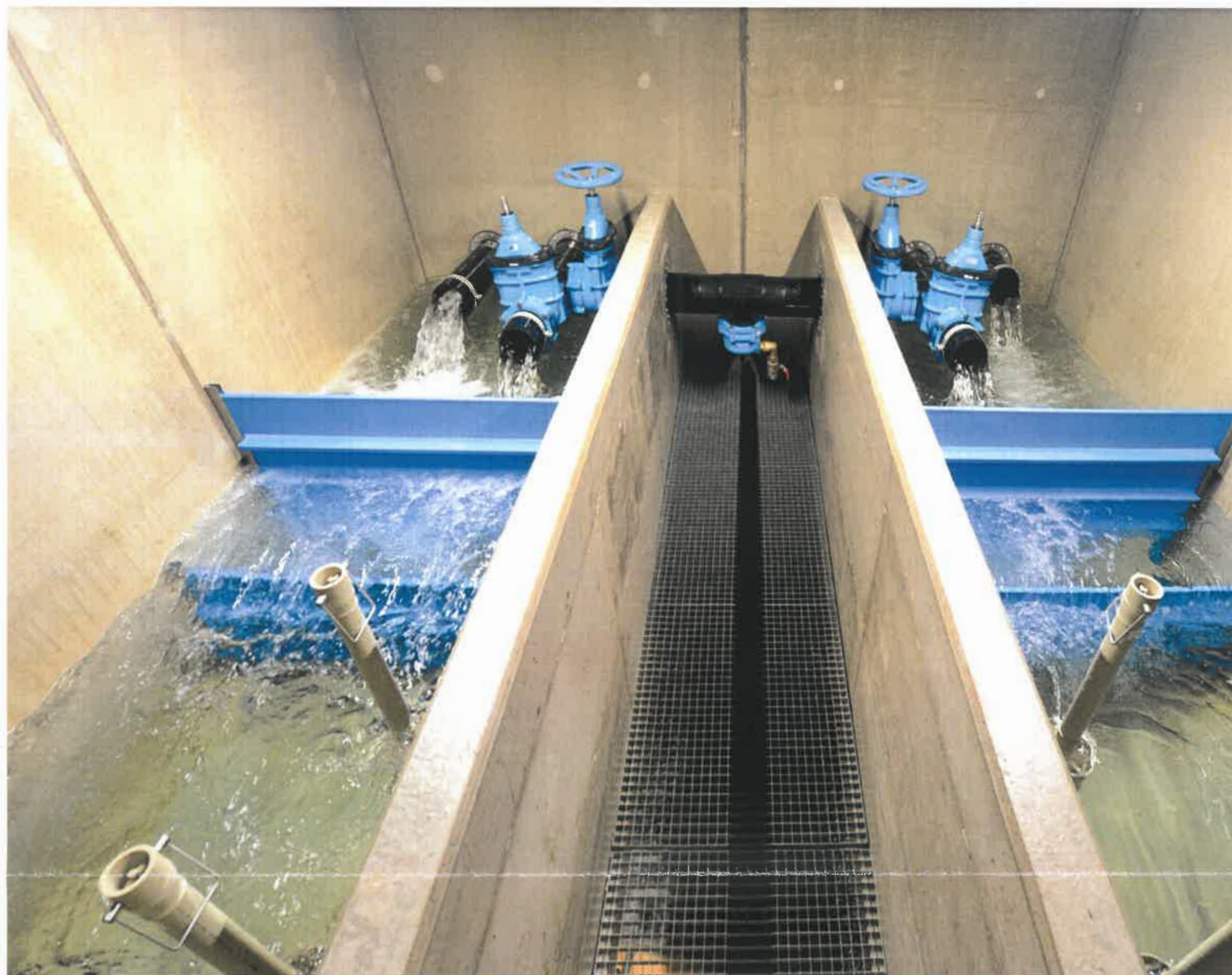
Seit der Neufassung liefern die Gätteri-Quellen jede Minute rund 3000 bis 5000 Liter Frischwasser in die neu erstellte Brunnenstube. Rund 2000 Liter davon werden seit dem 3. November 2023 mittels einer neuen, 544 Meter langen PE225-Leitung der Wasseraufbereitungsanlage Wasserauen zugeführt. Genutzt werden dürfen aber gemäss Konzession nur 2200 Liter pro Minute. (Bilder: H9)
