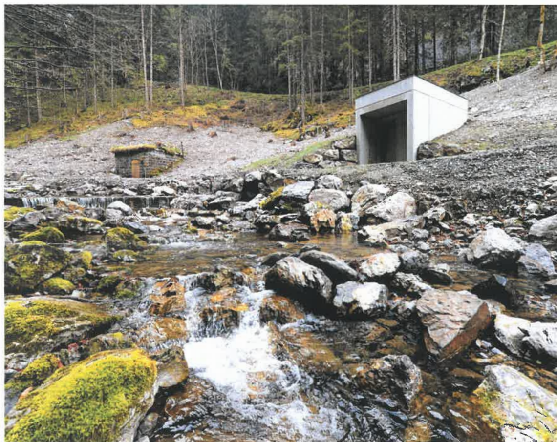
Etwa 30 Meter talwärts zur alten steht nun die neue Gätteri-Brunnenstube, deren vorfabrizierten doppelwandigen und bis zu vier Meter hohen sowie 2,4 Tonnen schweren Betonelemente am 3. Oktober 2023 mit einem K-Max-Transporthubschrauber auf die Baustelle geflogen worden waren. Vor Ort wurden sie hernach mit Flüssigbeton aufgefüllt. Das Areal unterhalb der Strasse zum Seelalpsee kann nach dem Eingriff nun wieder verwachsen.
